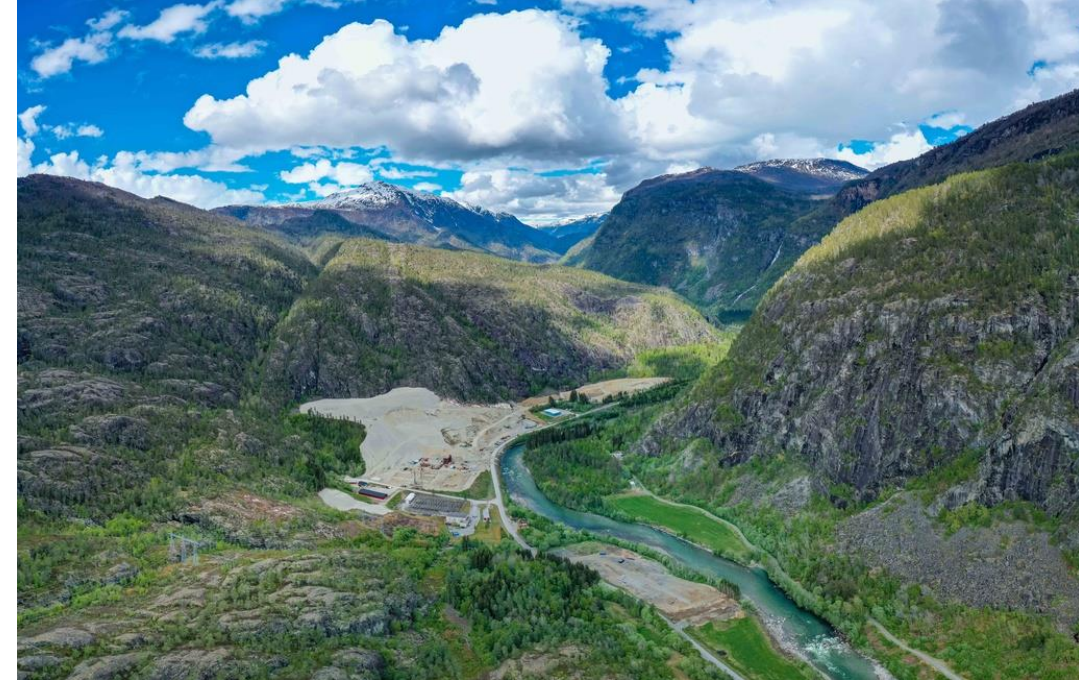
Bygging av Leirdøla transformatorstasjon
