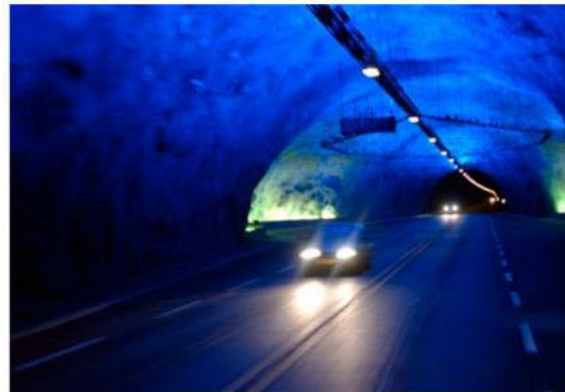
Lærdalstunnelen, med sine karakteristiske lyspunkt underveis, skal utbedres av Transportbransjen krever kolonnekjøring mens arbeidet pågår. Foto: BERGENS
