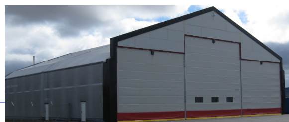
Isolert plasthall på Røros lufthavn
