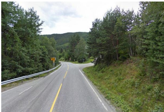
Figur 13 «Gamal riksveg» før avkøyrsla til flyplassvegen
