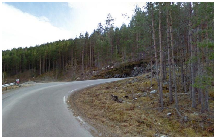
Figur 4 Bilete syner slyng 1, R_h = 14m og stigning på 8,26%
