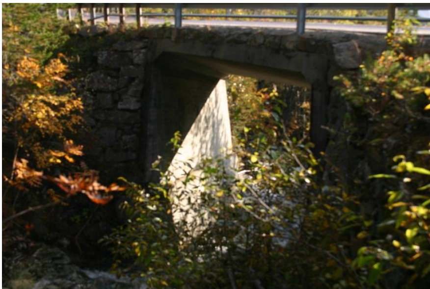
Figur 9 Eksisterande bru, pel 4730 - 4760
